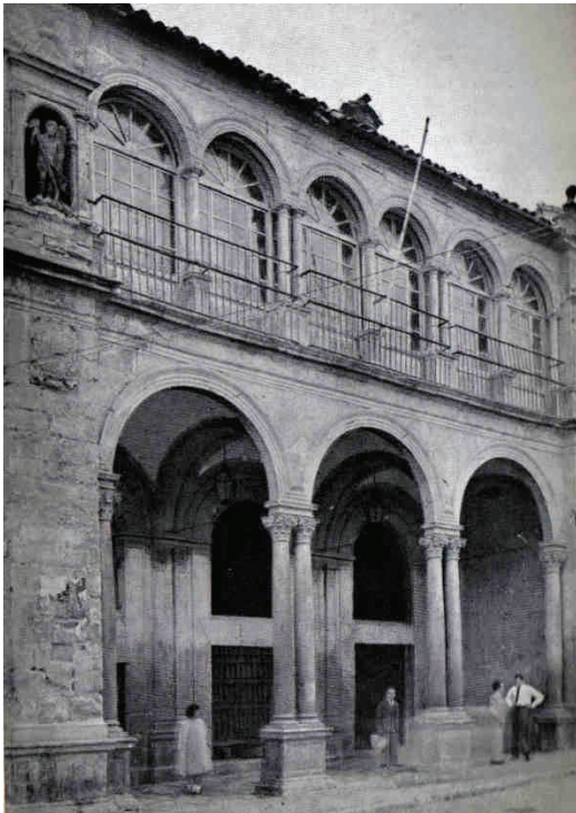
Fig.2. Antiguas casas consistoriales, Úbeda.
