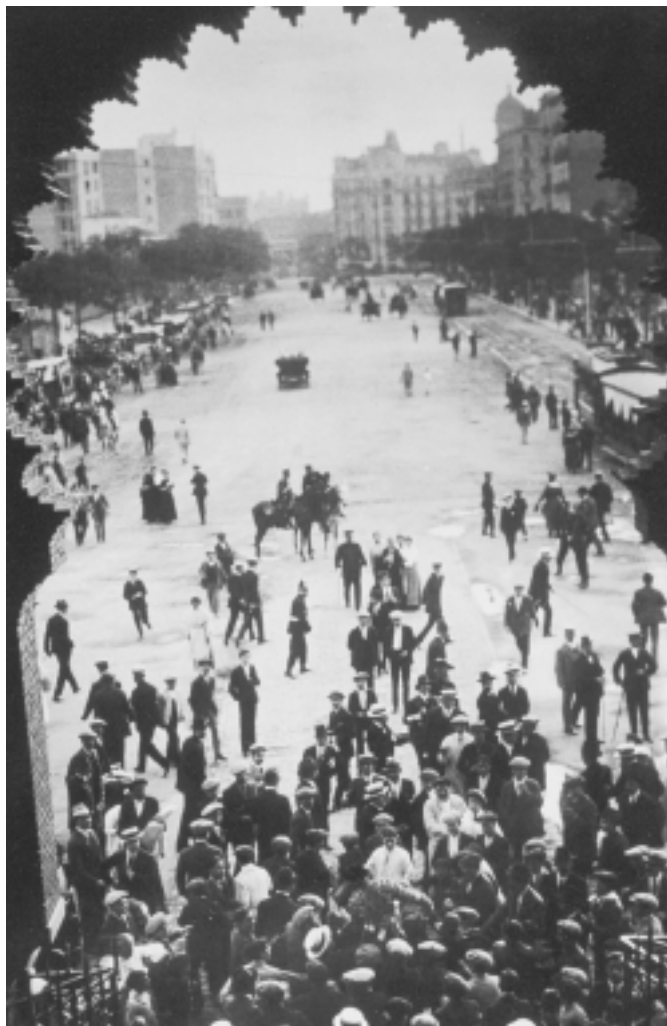
Fig. n.º 20.– La puerta principal de la Plaza de Toros Monumental de Madrid (apud Martínez-Novillo: Baldomero y Aguayo. Fotógrafos taurinos , Catálogo de Exposición, Madrid, Turner/Centro de Asuntos Taurinos, 1991).
