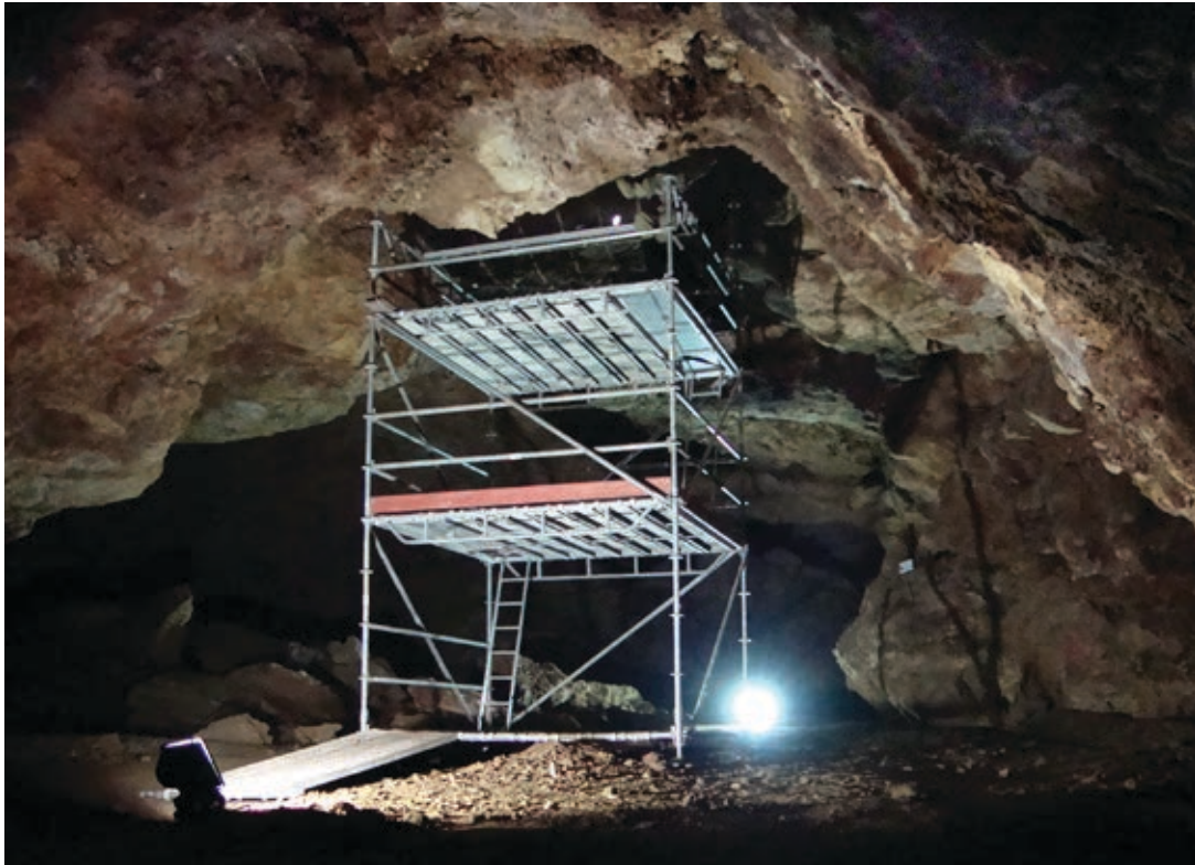
Fig. 9. Andamio en la Sala Victoria II, instalado en 2010, que permitió acceder a la brecha in situ del techo.
