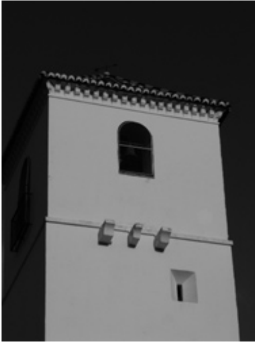
3.-Restos de maticán en el campanario de la iglesia de San Juan (torre N.E. de la alcazaba).
