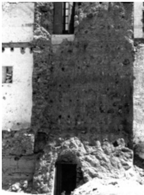
5.-Restos de torre en las obras de derribo del antiguo Palacio Episcopal.
