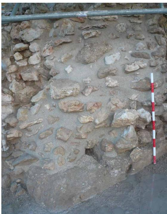
Lámina 15. *Bloques de tapial hormigonado hallados bajo la torre C1. Restos del primer castillo de Moçlín*
