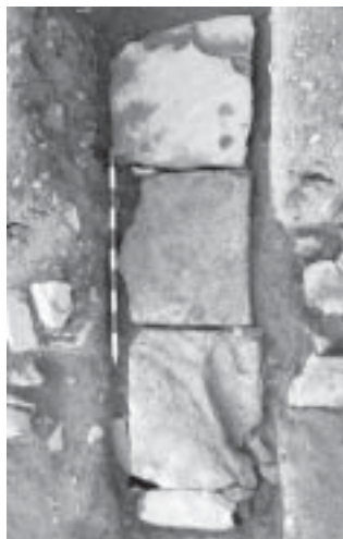
Cubierta de la T-9
