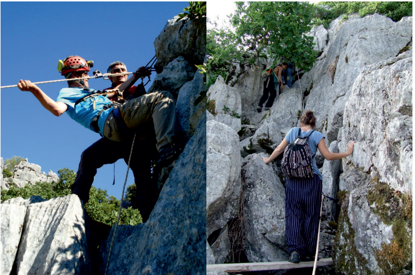
Preparación de tirolina para evacuación de materiales y adecuación del acceso
