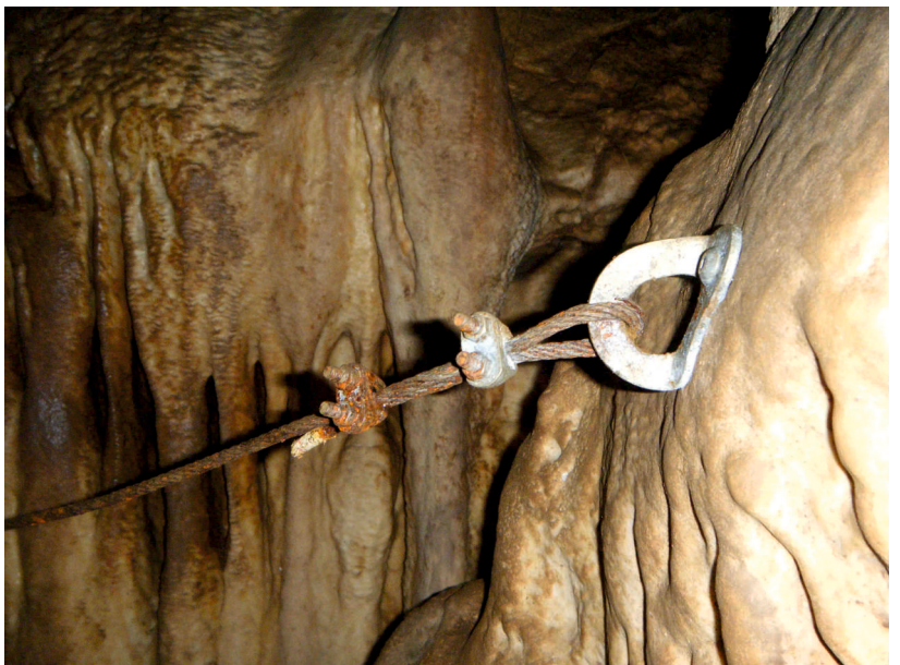
Un detalle de la instalación del pasamanos de Covalinda, tal como la encontramos (febrero de 2013), después de 16 años.
