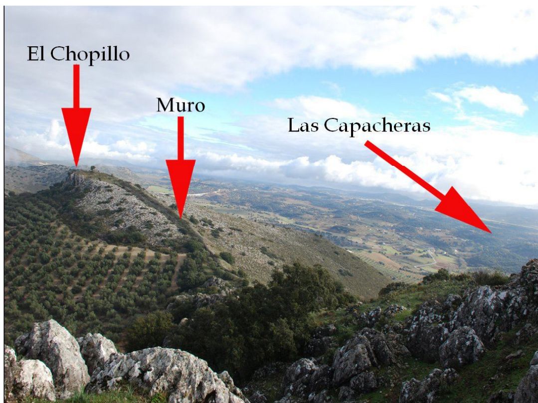
Figura nº 30. Situación de “El Chopillo”, el “Muro” y “Las Capacheras”
