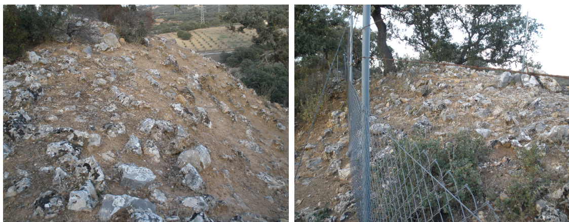
Figuras 13 y 14. El recinto de Las Capacheras
