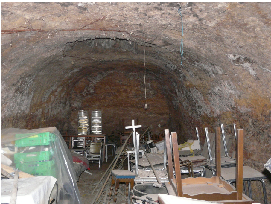
Figura 44. Una de las cuevas-bodega entre la Calle Nueva y Calle Ejio
