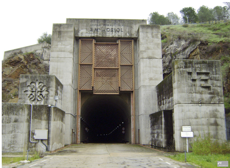
Figura 15. Antonio Santonja. Puerta de la Central de Alcántara. 1972. Foto cortesía Archivo Iberdrola.
