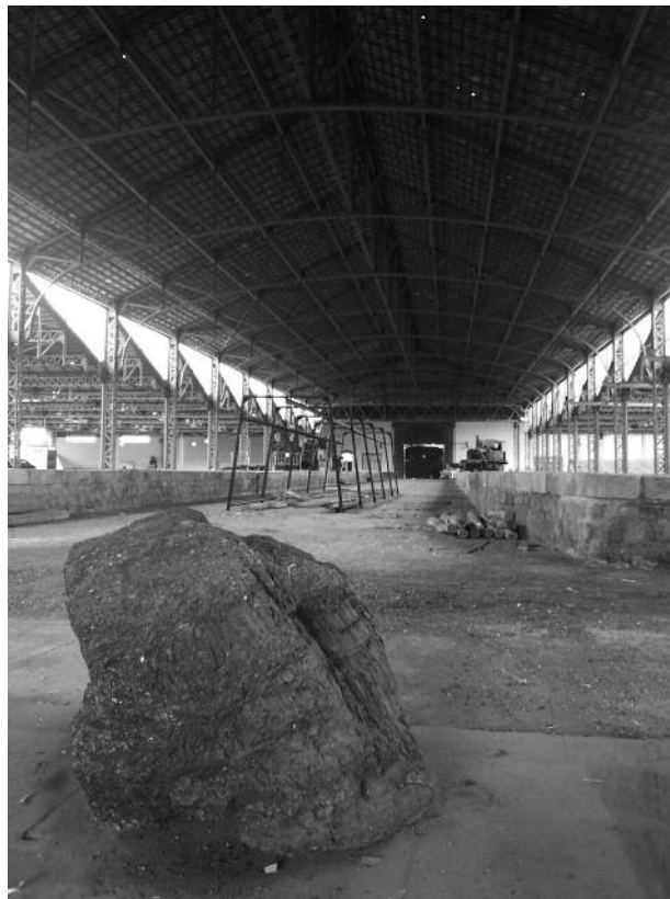
Figura 3. Almacén Central de la SMMP, Peñarroya-Pueblonuevo, tras su restauración.
