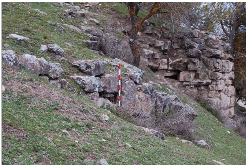
Lámina 2. Vista lateral del muro de aparejo ciclópeo en el Cerro del Castillo (AEAB)
