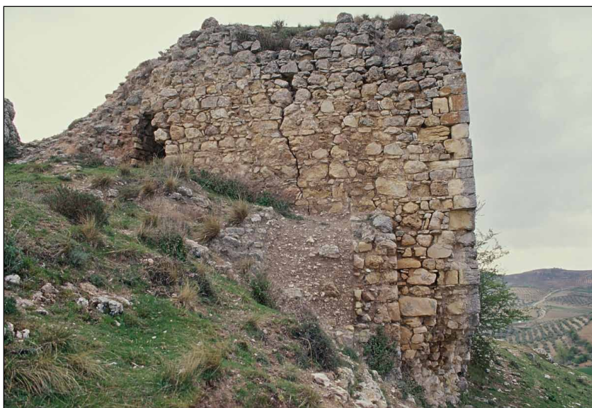
Lámina 5. Vista del frente septentrional de la torre meridional del castillo con los tres lienzos superpuestos (AEAB)
