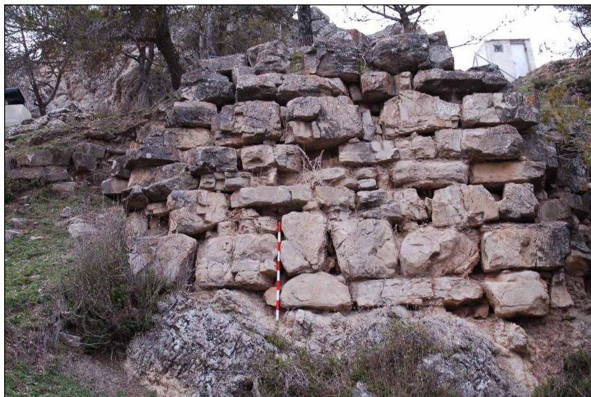
Lámina 3. Vista frontal del muro de aparejo ciclópeo en la ladera oriental del Cerro del Castillo (AEAB)
