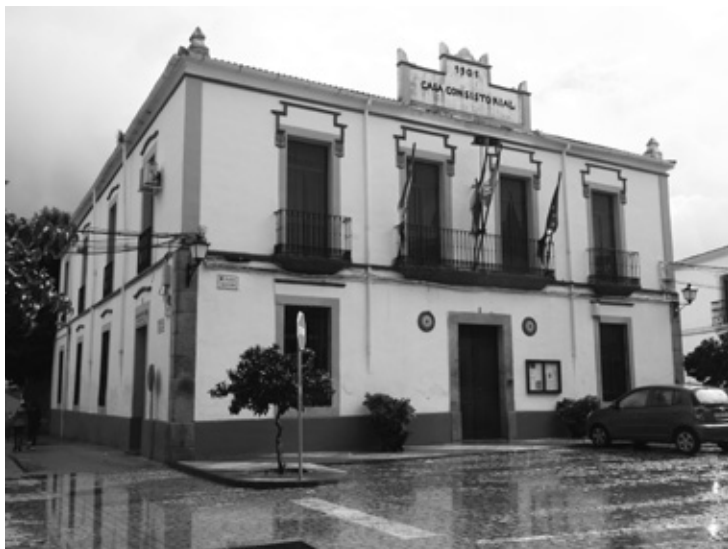
14. Fachada actual del Ayuntamiento de Aldea del Cano
