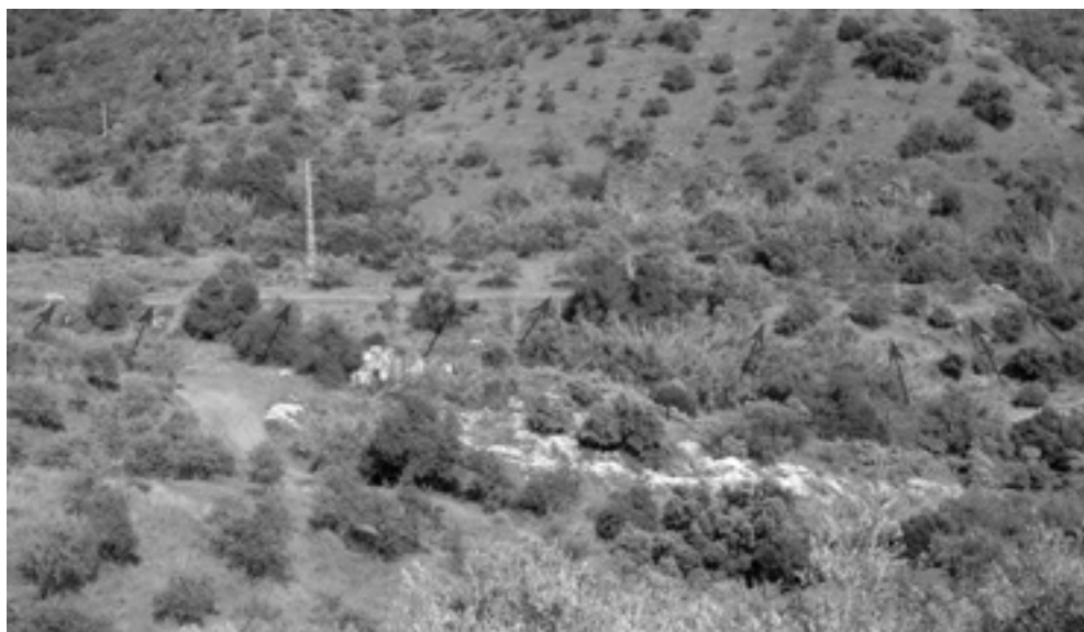
El muro en su limite Oeste
