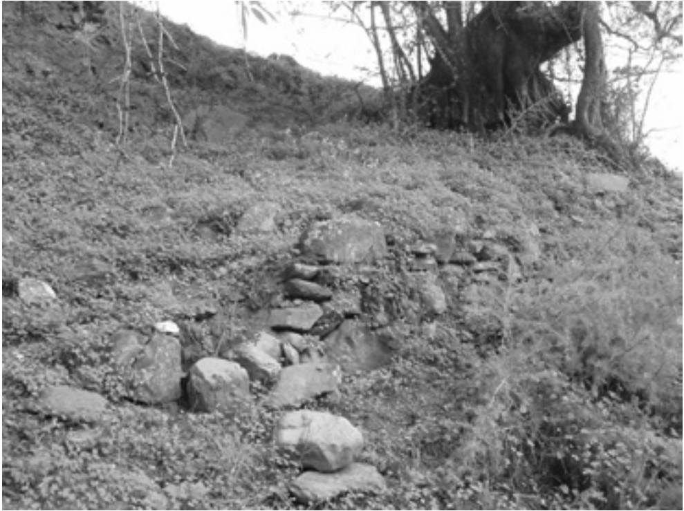
Camino en rampa para la entrada desde el arroyo
