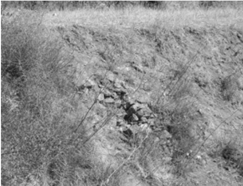
Contrafuerte del muro Oeste
