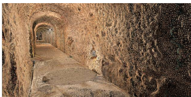
Figura 4. Vista isométrica del modelo 3D exenta del resto de estructuras y detalle de la malla triangulada. Cloaca de Caesarangusta.
