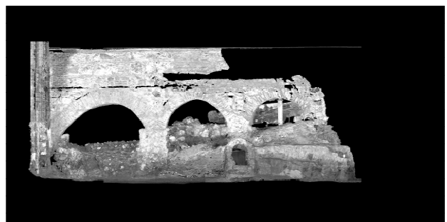
Fig. 7. Escaneo laser del acueducto de Amanuel.
