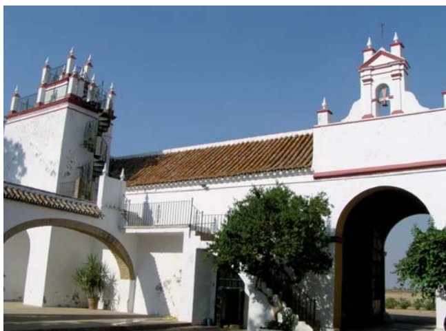
INTERIOR DE PATIO PRINCIPAL. (AMP-ICG)
