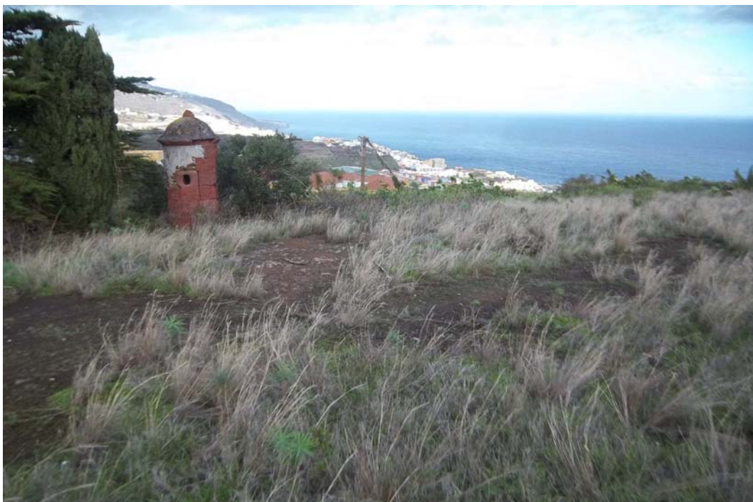
Vistas de la garita y zona del antiguo torreón. 2012
