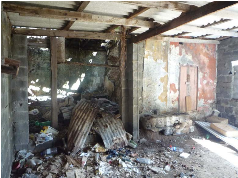
Figs. 19 y 20: Vistas de la caseta destinada a cuerpo de guardia. En primer plano el garaje de la vivienda de Antonio Isidro
