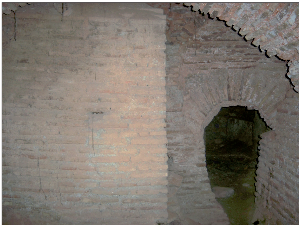
Lámina 6. Tercer tramo del foso de la Bab al-Sari'a. (CVV. 2010)
