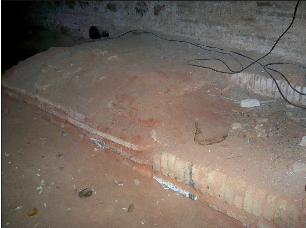
Lámina 3. Arranque del machón de la escalera de subida a la planta primera de la torre de la Bab al-Sari'a. (CVV. 2010)
