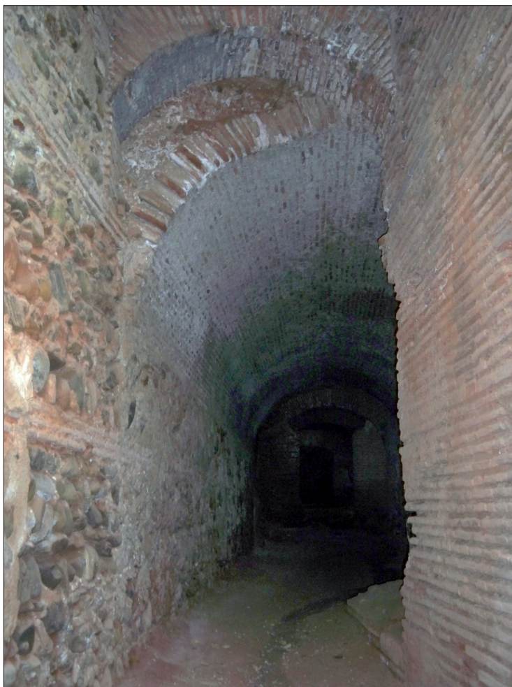
Lámina 2. Primer tramo del foso de la Bab al-Sari'a. (CVV. 2010)
