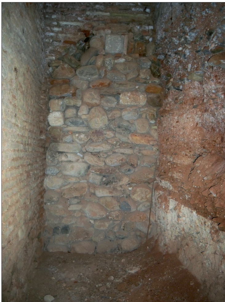
Lámina 8. Muro de mampostería que cierra el final del foso de la Bab al-Sari'a. (CVV. 2010)
