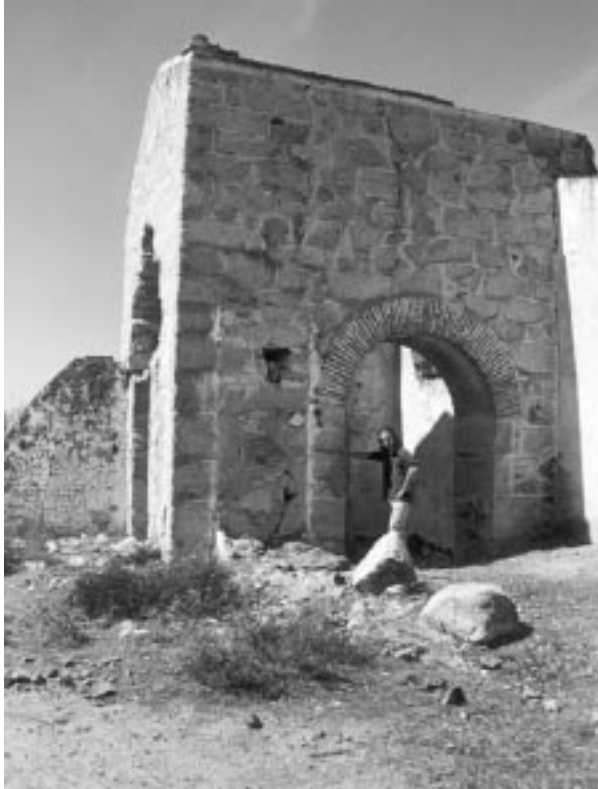
Pozo principal de las antiguas minas de Colmenarejo
