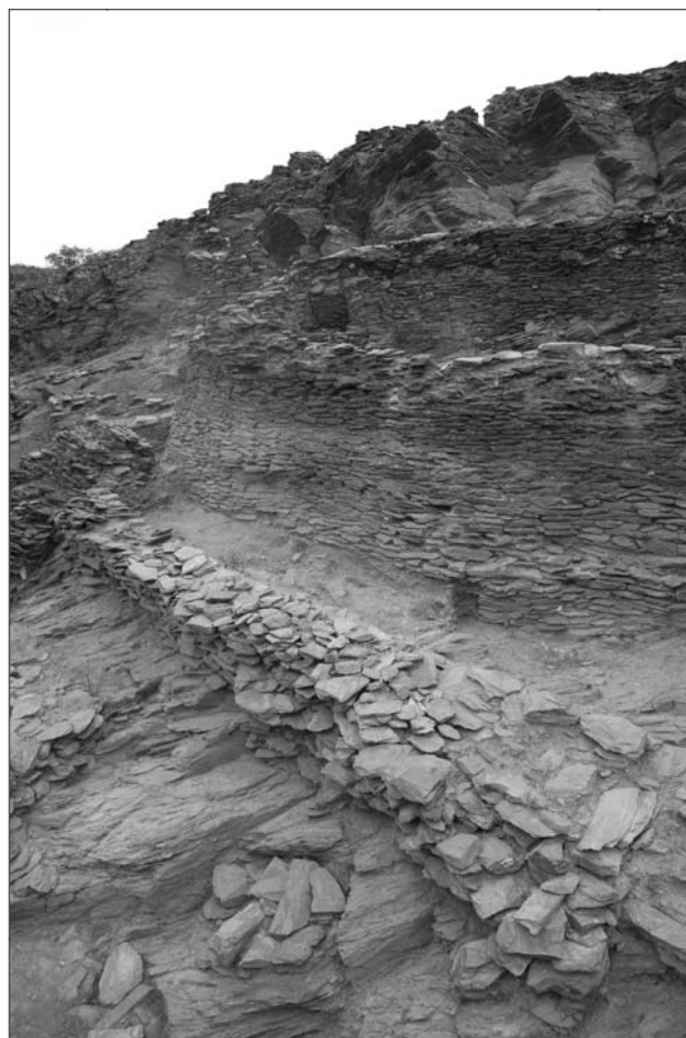
Lámina 15. Peñalosa. Paso de ronda.
