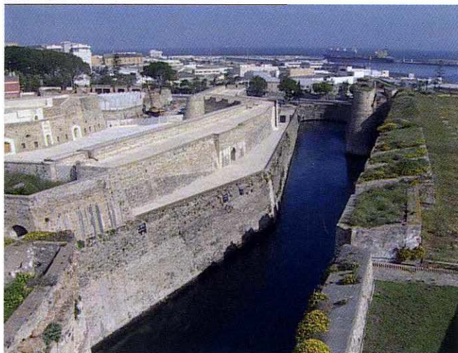
Foso Real con la escarpa a la derecha y la contraescarpa a la izquierda. Foto J.J. Gutiérrez
