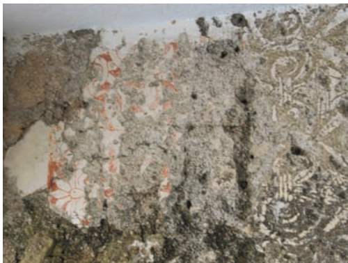
Pintura mural en la fachada de la Epístola
