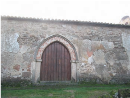
Portada del muro del Evangelio
