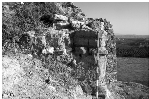
Lám. 14: Jamba septentrional de la puerta con la superposición de dos estructuras, UE 013 y 014.
