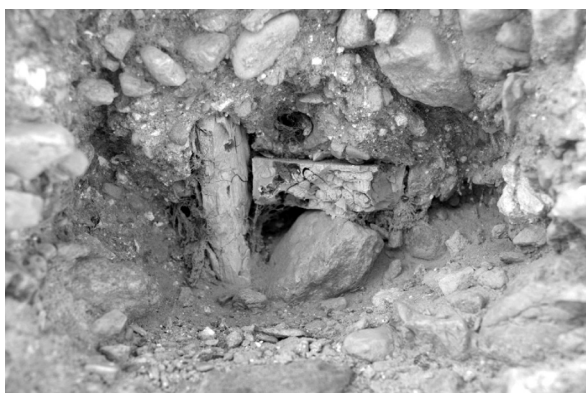
Lám. 24: Detalle constructivo del tapial. Agujas sujetas con cuerdas y cuñas.
