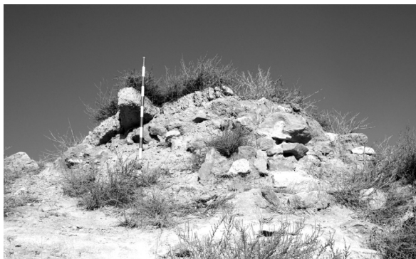
Lám. 11: Derrumbe de estructuras de tapial sobre otras de mampostería en la zona de la puerta principal del castillo.
