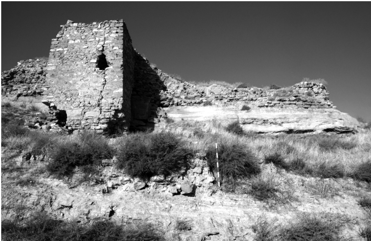
Lám. 10: Restos de la barbacana donde puede apreciarse bien la fábrica de mampostería.
