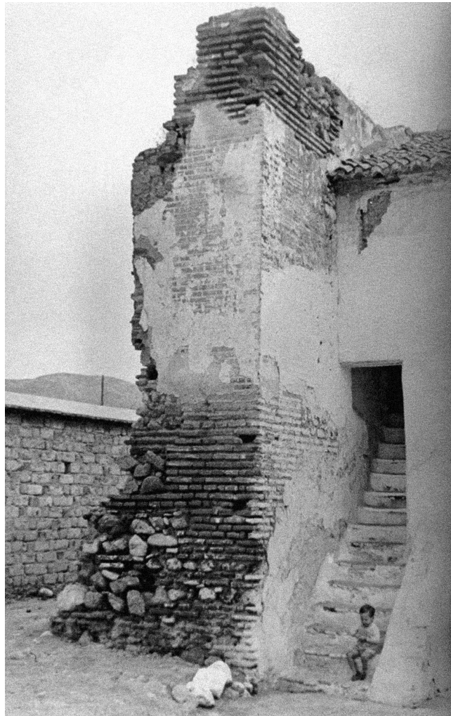
Angulo S. W. de la Iglesia derrivado y hecho viviendas, 1946
