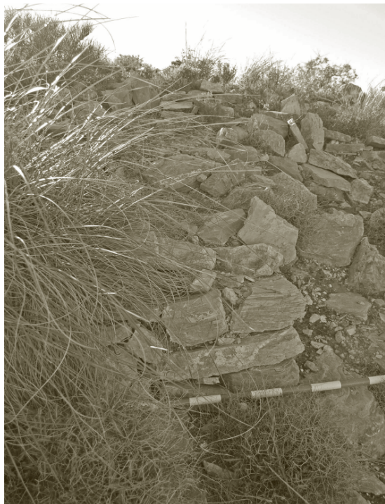
Lám. VI. Torre 1 del Bastión angular 1
