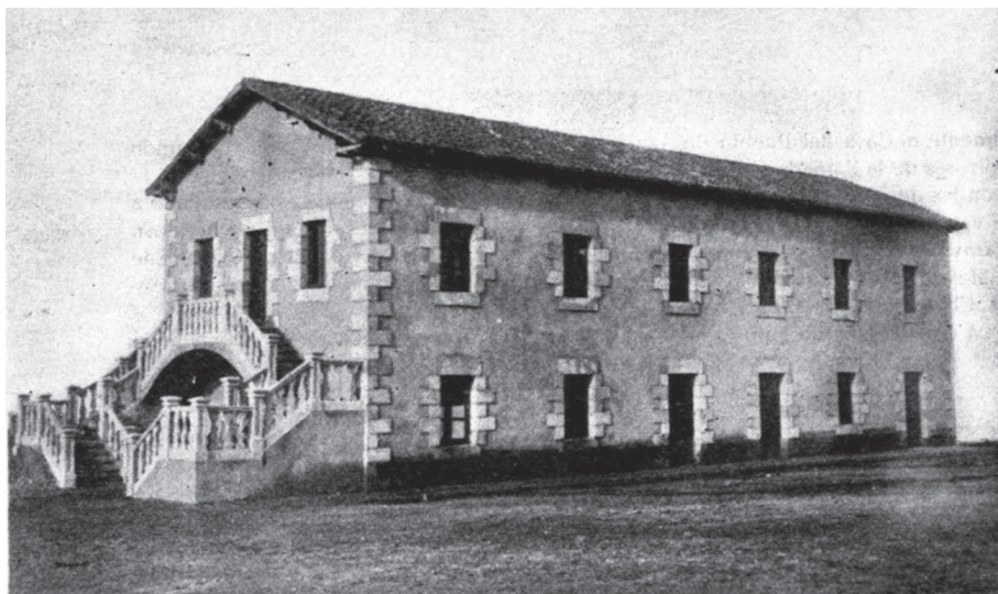
Fig. 3.- Casa del Pueblo de Arija, Burgos, Boletín de la UGT , (1933).
