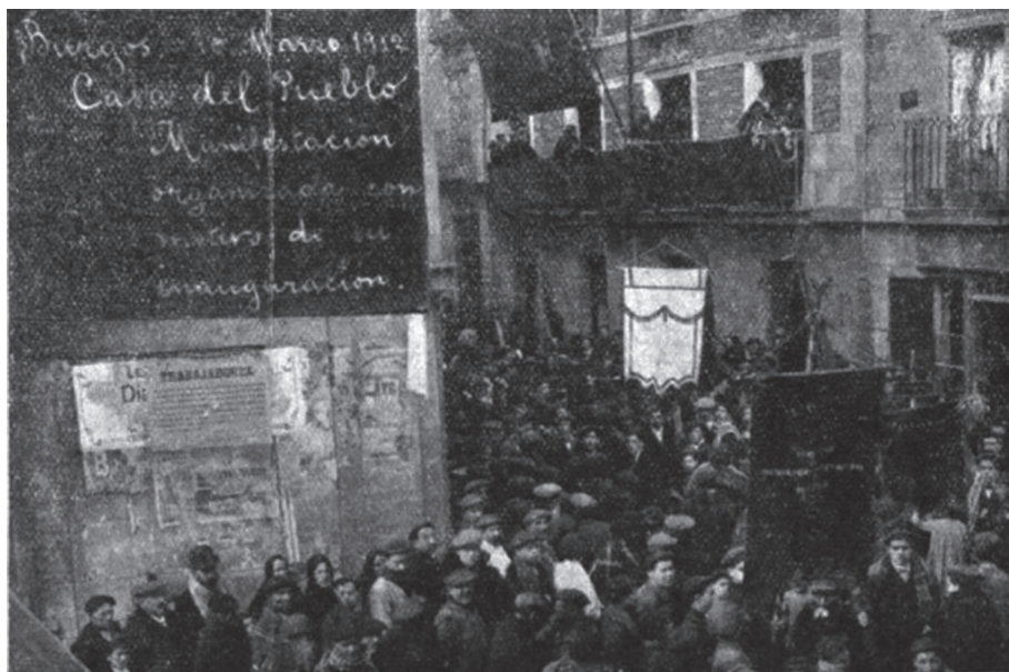
Fig. 2.- Inauguración de la Casa del Pueblo de Burgos, 1912.
