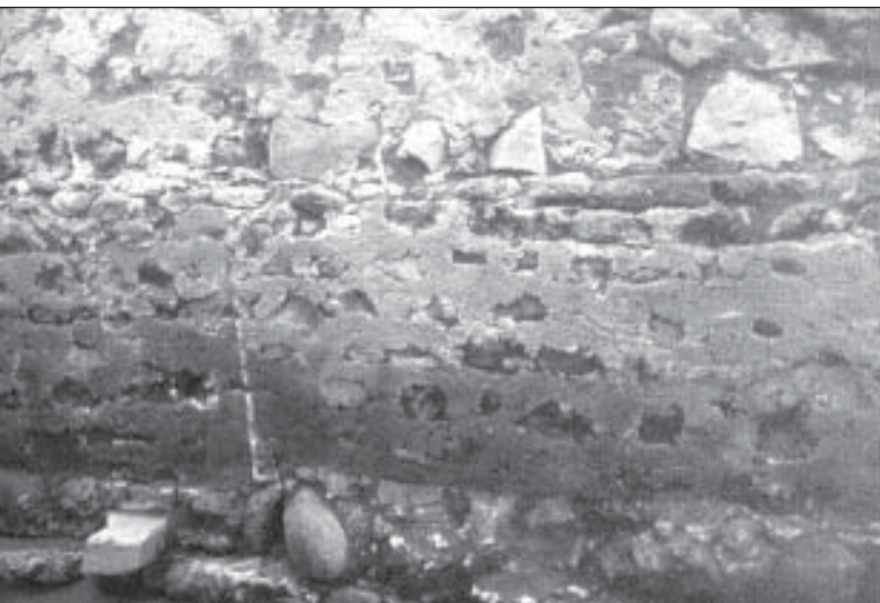
⊗ Paramento exterior de los muros de fachada. El llagueado de cal deja visibles las piedras
