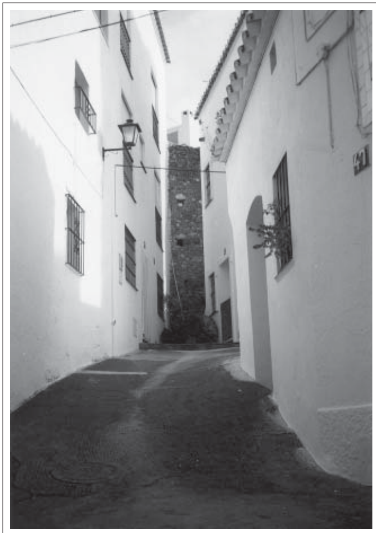
⊗ Vivienda adosada al muro Oeste de la Torre de Escalante
