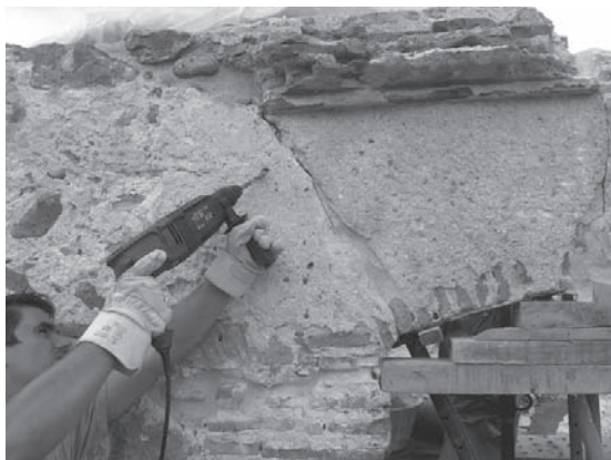
Lámina 31. Perforación para la introducción de las varillas que unen los bloques.
