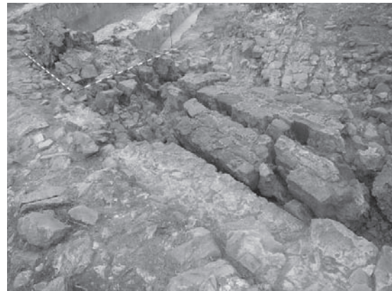
Lámina 25. Destrucción del fuerte. Obsérvense las líneas de rotura longitudinales del muro desplomado.
