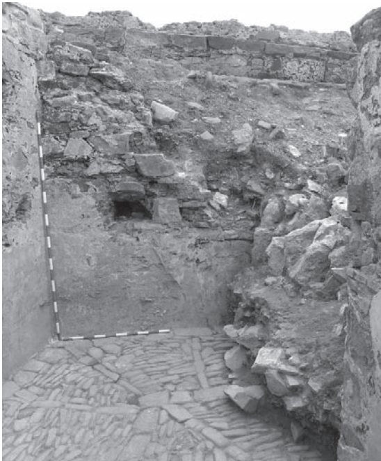
Lámina 16. Pavimento que circunda el polvorín. En la parte superior se localiza el camino de ronda en dos alturas.
