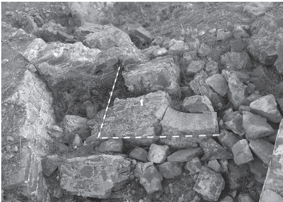
Lámina 28. Derrumbe con el despiece completo de la puerta de acceso al polvorín.
