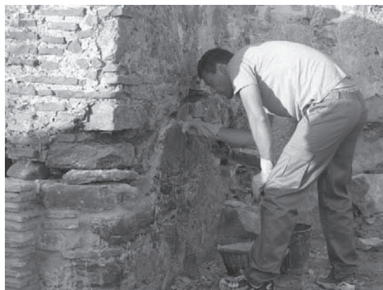
Lámina 32. Sellado de la unión entre los bloques con mortero.
