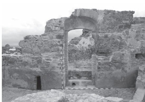
Lámina 34. La puerta de acceso al polvorín tras su reconstrucción.
