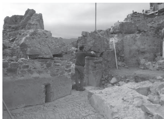
Lámina 30. Colocación de un bloque en su posición original.
