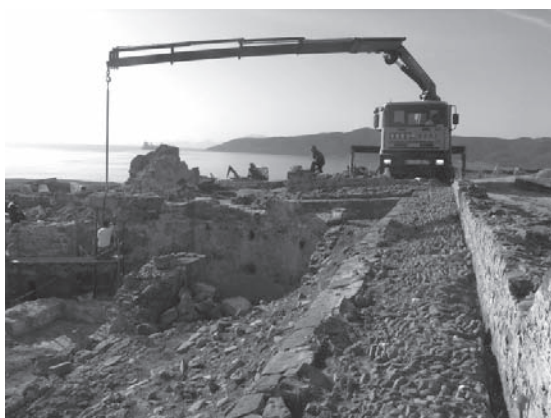
Lámina 29. Elevación y desplazamiento de los bloques de la puerta del polvorín.
