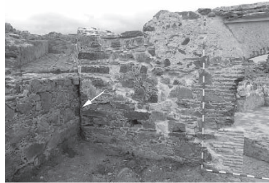
Lámina 14. Muros adosados en el Sector A.
