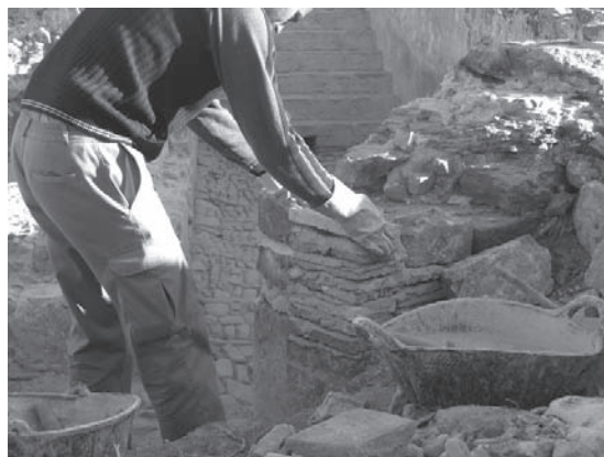
Lámina 33. Reconstrucción de la jamba con ladrillos originales obtenidos en la excavación.
