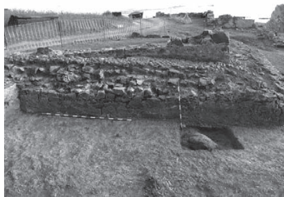
Lámina 23. Muro de contención norte. Nótese el desnivel del terreno y la escasa cimentación del muro.
