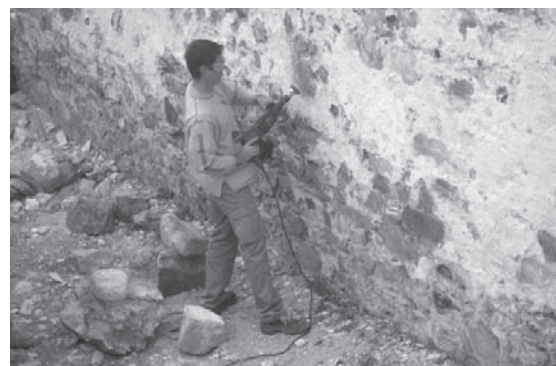
Lámina 36. Eliminación mecánica de los grafitis.
