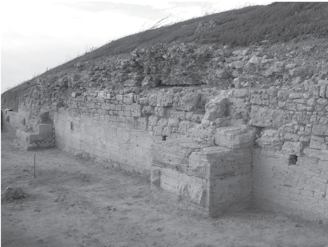
Lámina 6. Muro romano y torres-contrafuertes, en el lado Este.
