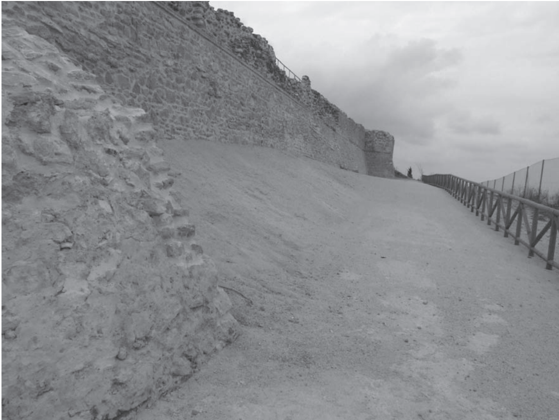
Lámina 3. Puesta en valor del paseo perimetral externo.
