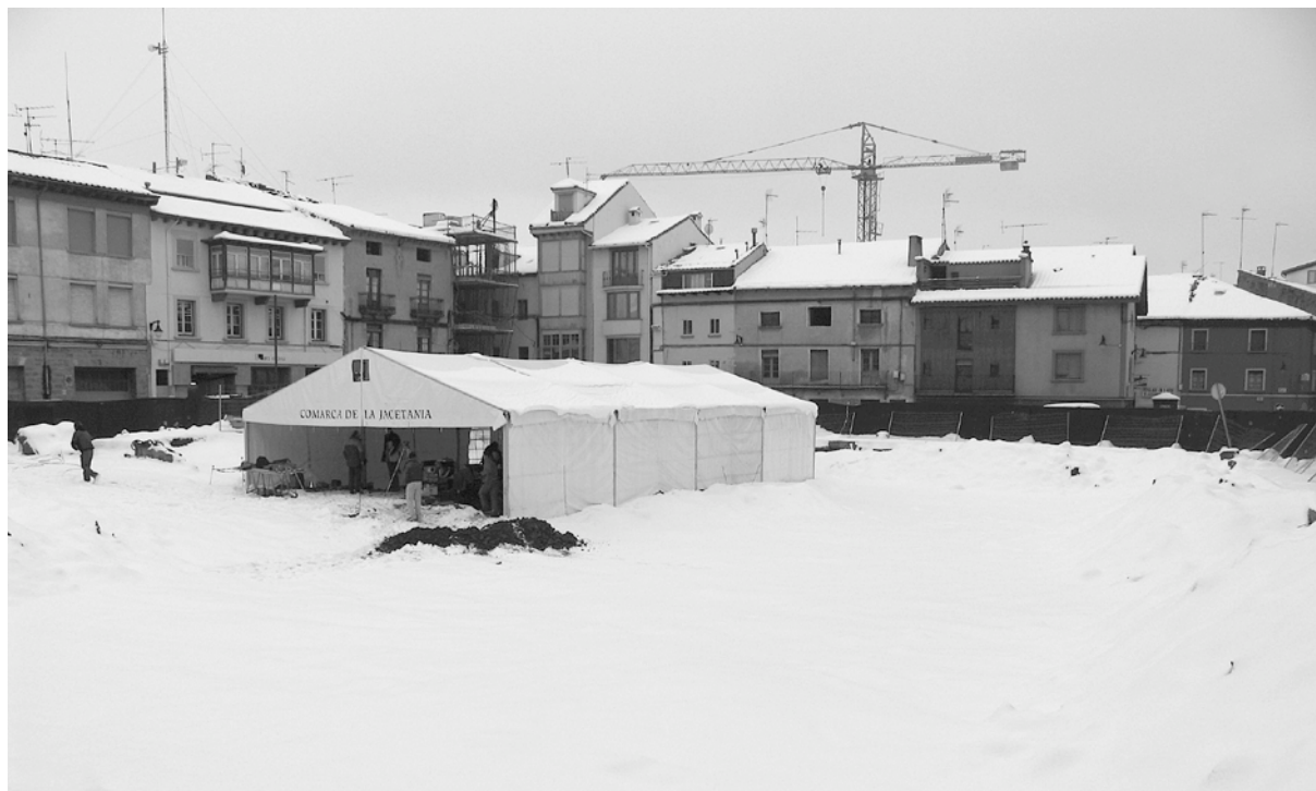
Figura 2. Aspecto de la Plaza Biscós bajo la nieve el 30 de enero de 2006. La carpa instalada al efecto por la Comarca de la Jacetania permite continuar los trabajos en la zona central de la plaza, en ese momento única sin excavar.
