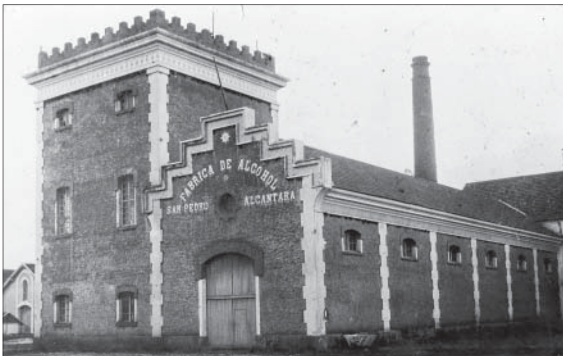
Uno de los edificios industriales de la antigua colonia de San Pedro Alcántara que sirvió de centro de acogida de refugiados, en el barrio de El Ingenio. Fotografía: Facilitada por José Luis Casado Bellagarza
