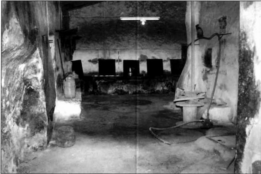
FOTO 17: Situación de los depósitos de decantación (20-22), hogar (24), rebancos (23 y 25), y al fondo, los tinajeros (26).
