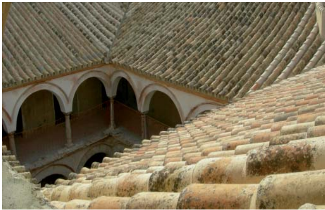
CUBIERTA DE CUERPO PERIMETRAL DE PATIO PRINCIPAL
