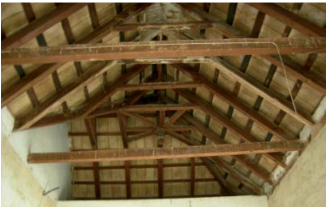
CUBIERTA ORIGINAL DEL CUERPO PERIMETRAL DE PATIO INTERMEDIO
