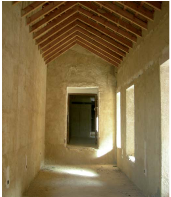
NUEVAS CUBIERTAS Y DESNIVEL EN CUERPO PRINCIPAL
