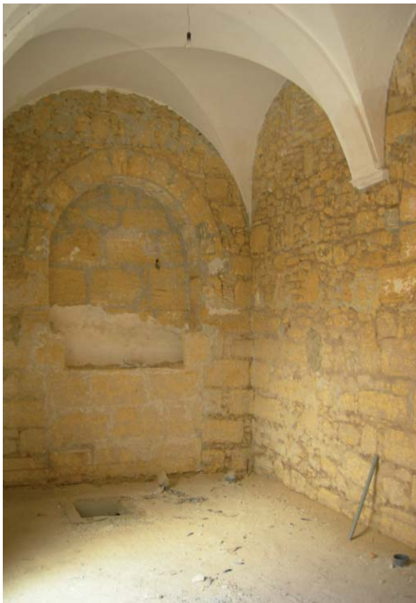
ZONA FUTURA DE ASEOS DE PÚBLICO CON SILLAR CARA VISTA
