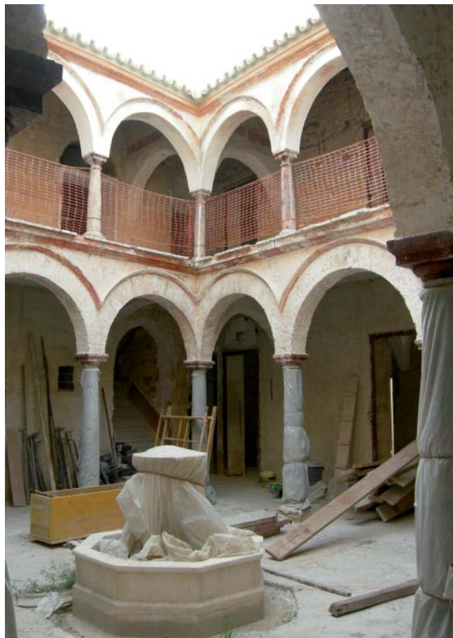
ARCADAS DEL PATIO PRINCIPAL VACIADAS CON LADRILLO A COLOR
