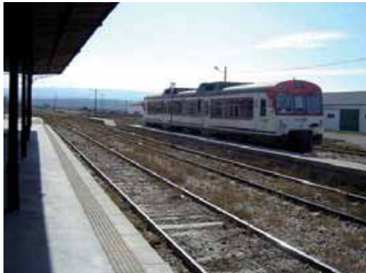
FIG. 1. EL DESCUIDADO APEADERO
