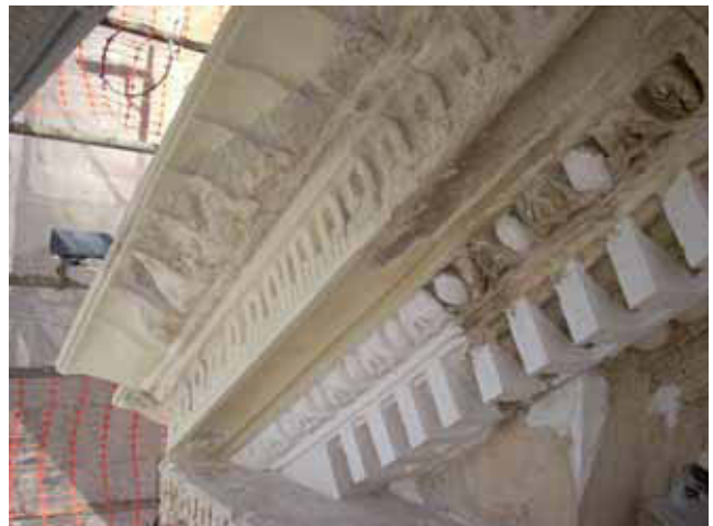
ESTRUCTURA REALIZADA CON VARILLAS DE FIBRA DE VIDRIO Y REINTEGRACIÓN CON MORTERO DE CAL
