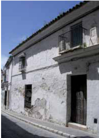
VIVIENDA CON SILLARES ENCALADOS EN LA CALLE SEVILLA
