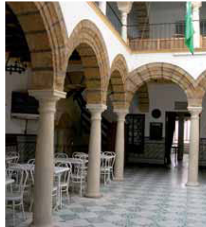
ARQUERÍA DE MEDIO PUNTO CON SILLARES AL DESCUBIERTO
