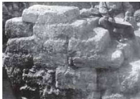
6. PARTICULAR DEL APAREJO EN EL CIERRE NORTE DEL MONUMENTO ESCALONADO
