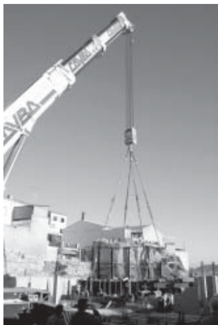
AAU de c/ Ramón y Cajal, 39. Traslado del horno de cal hispanorromano
