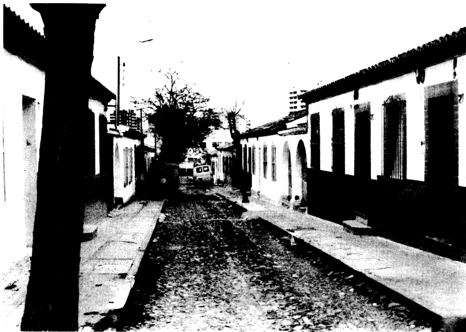
Foto n o 7. Barriada del Generalísimo Franco (Carranque). Conjunto de viviendas unifamiliares entre medianerías de marcado carácter ruralizante y situadas lateralmente con respecto al conjunto construido.
