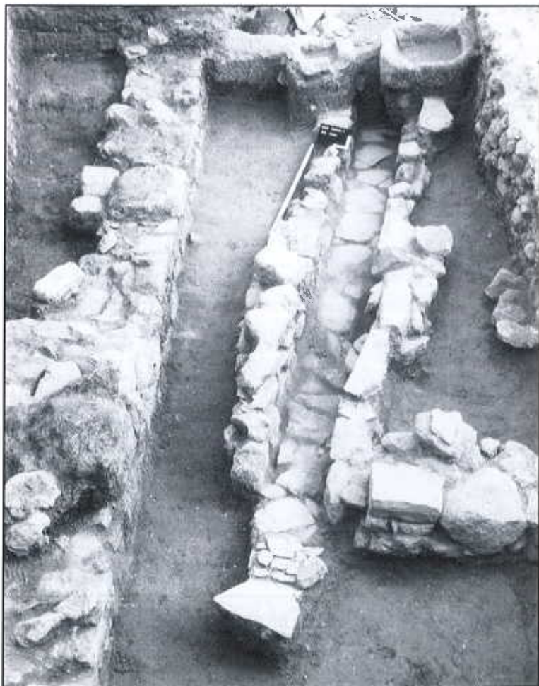
Lámina 4. Este desagüe discurre bajo un probable peristilo o zona abierta de una domus y enlaza perpendicularmente con la cloaca de la calzada (fotografía Ángeles Martínez). Nótese que ha perdido la cubierta.
