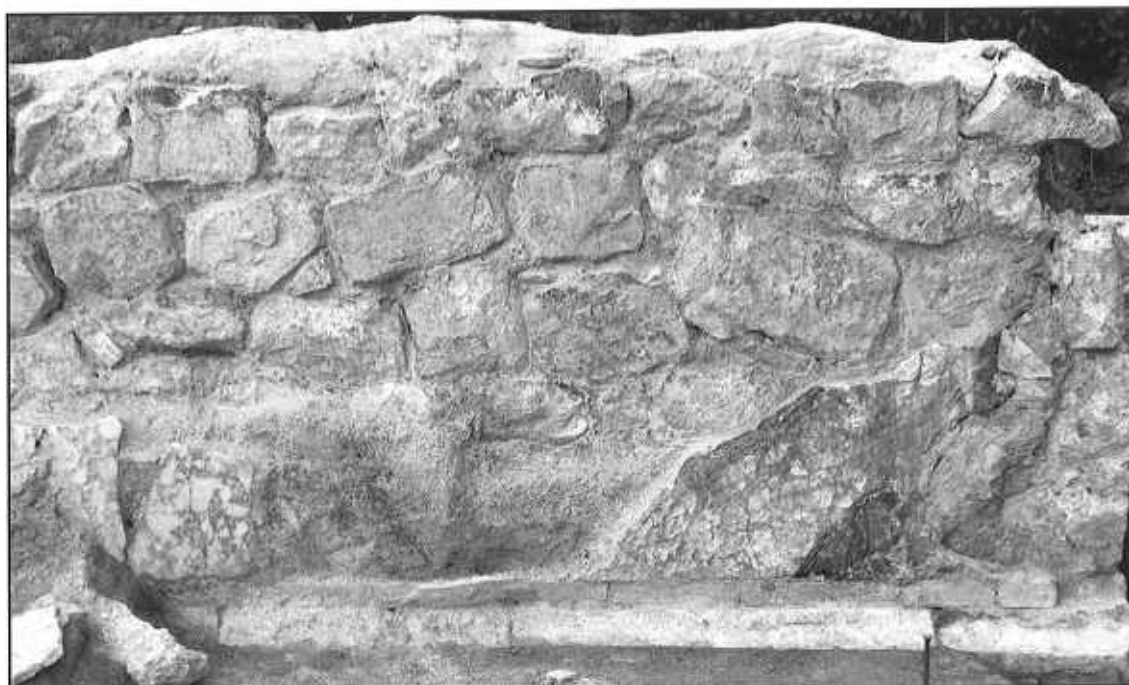
Lámina 13: Detalle del rodapié en kyma reversa, placas niveladoras y restos de las placas en "africano" y "pavonazetto" que revestían la pared.
