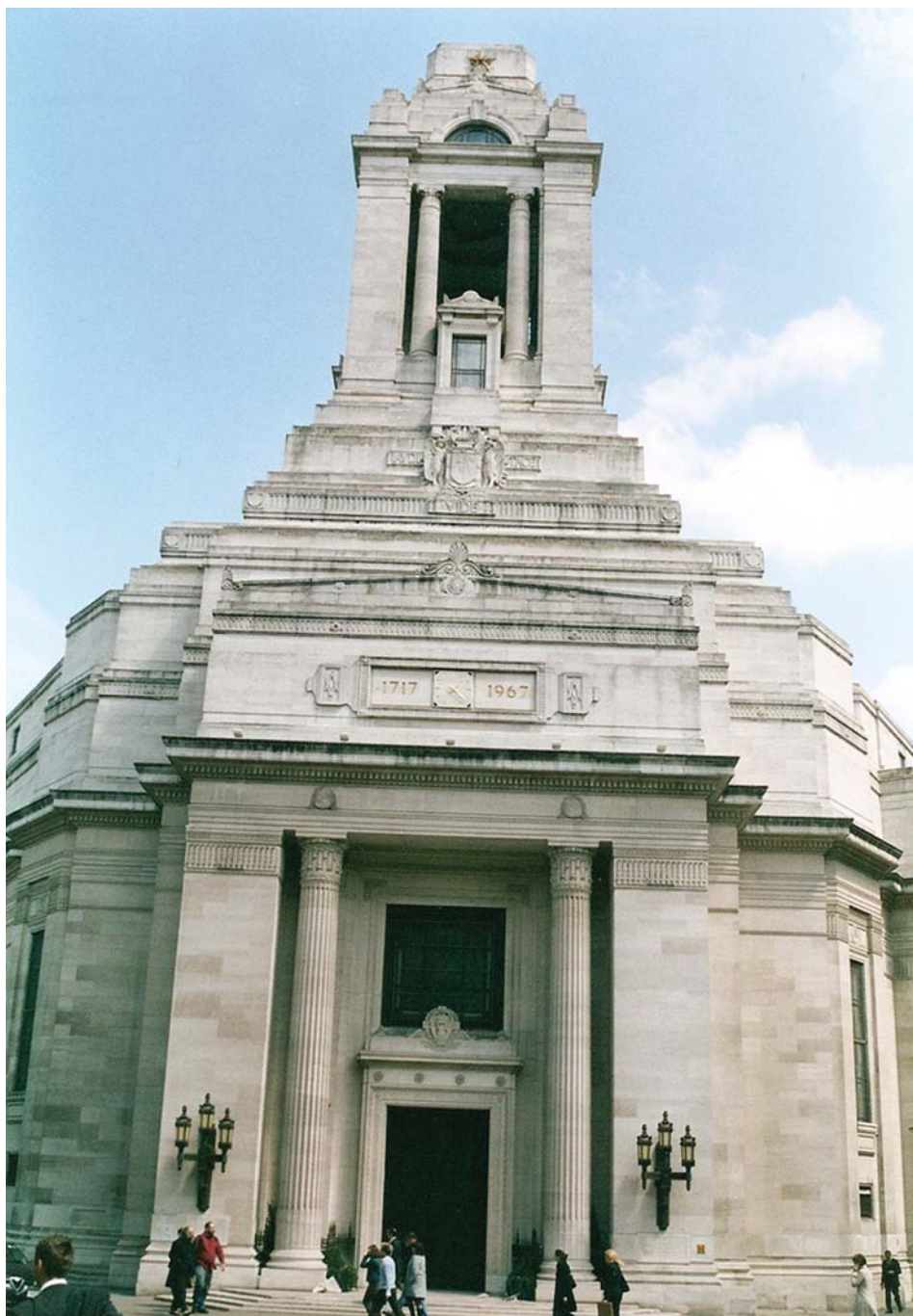
Edificio de la Gran Logia Unida de Inglaterra (Londres).
