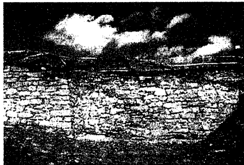
FIGURA 16: Barbacá entre o bastión e o talude.
