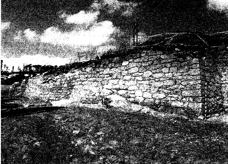
FIGURA 13: Vista da Barbacá Leste trala limpeza.
