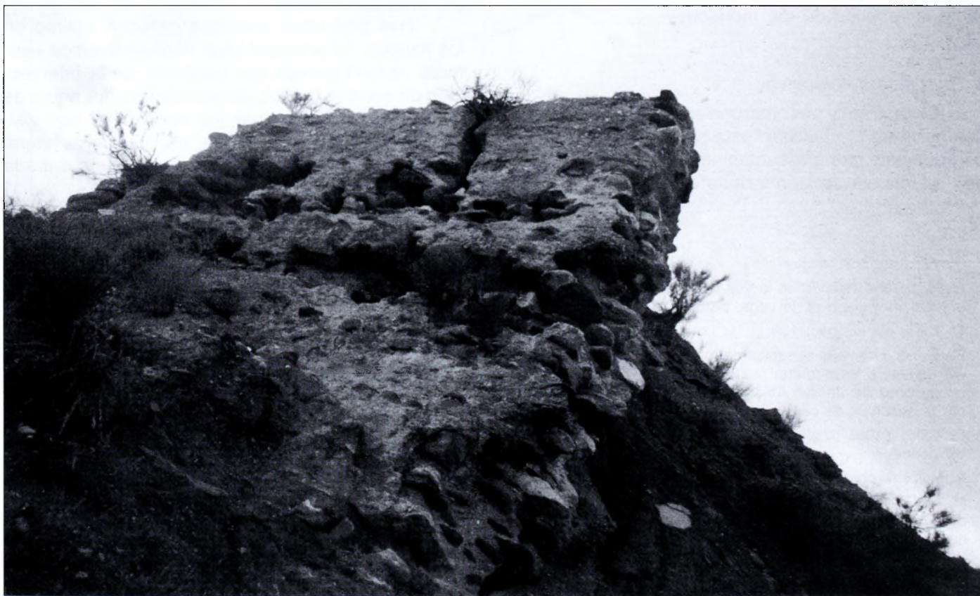
Lám. 2. La pared del baluarte superior, el resto más visible hoy de la fortaleza.
