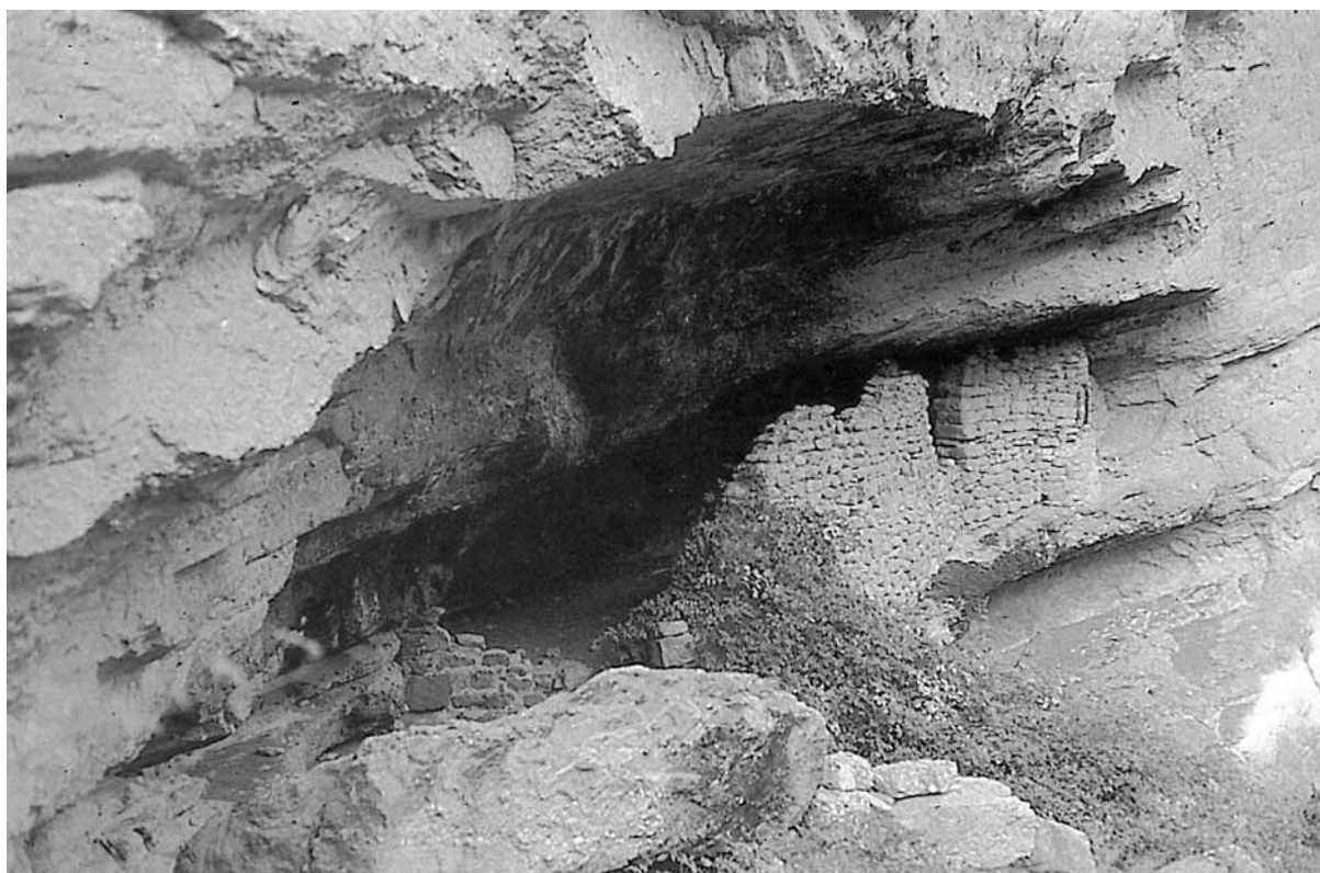
Figura 1. Vista del abrigo y construcción eremítica de San Chinés (Vadiello, Loporzano).
