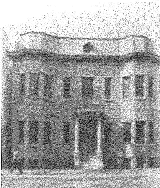
Edificio del Archivo Histórico de Santiago en 1917.
